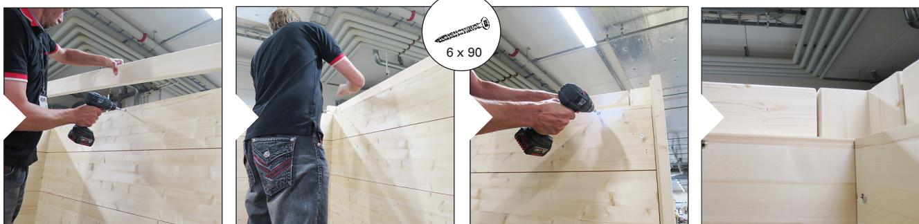
5. Montera takelementen. Skruva endast fast det första och det sista elementet. Montera den sista frontpanelen på framsidan.
