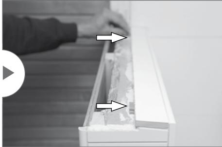
Lasin voi asentaa myös ilman U-listoja, mutta sitä ei saa asentaa suoraan betonin päälle. Laita lasin ja betonin välisiin pienet korokepalat (muovia).
