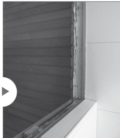
Kiinnitä kiinteän lasin U-listat lasilinjaan kaksipuoliteipillä. Varmista listojen kiinnitys parilla ruuvilla. Laita U-listan uraan liima- tai silikonitäpliä.
