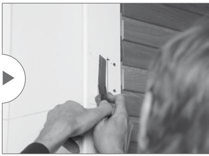
Laattaseinään on laitettava materiaalille sopivat tulpat. Lisää liimaa/silikonia tehtyihin reikiin.
