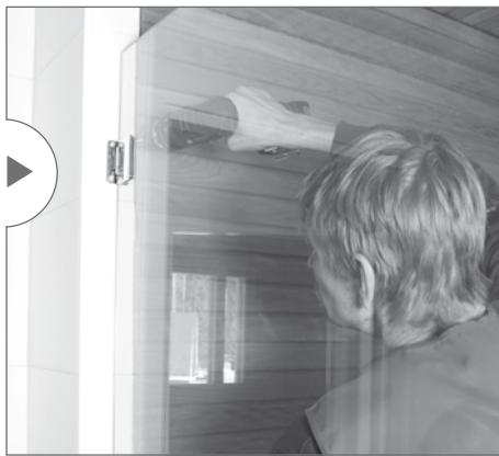
Asenna lasiovi paikoilleen ja kiinnitä se huolellisesti.
